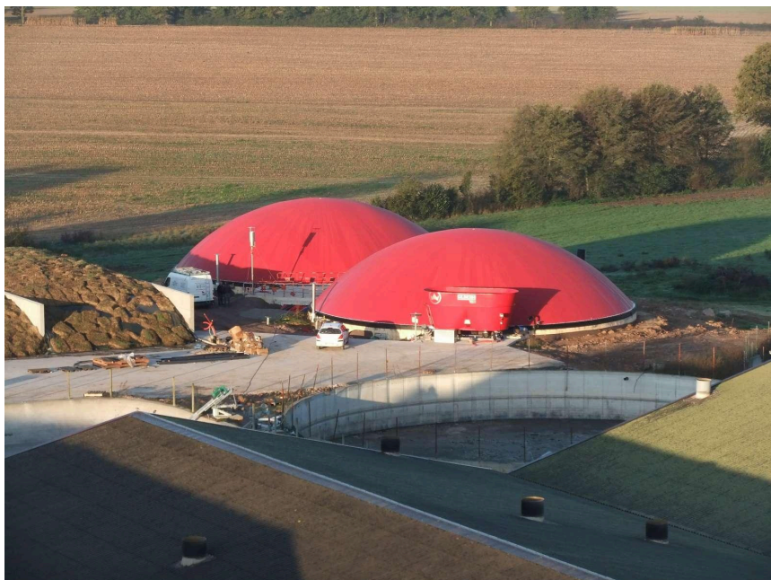
Méthaniseur en cogénération du GAEC De Roover
